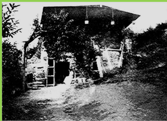
Die von Karl Gräser ausgebaute Weinberghausruine, später Gustos „Ruhinne“.
