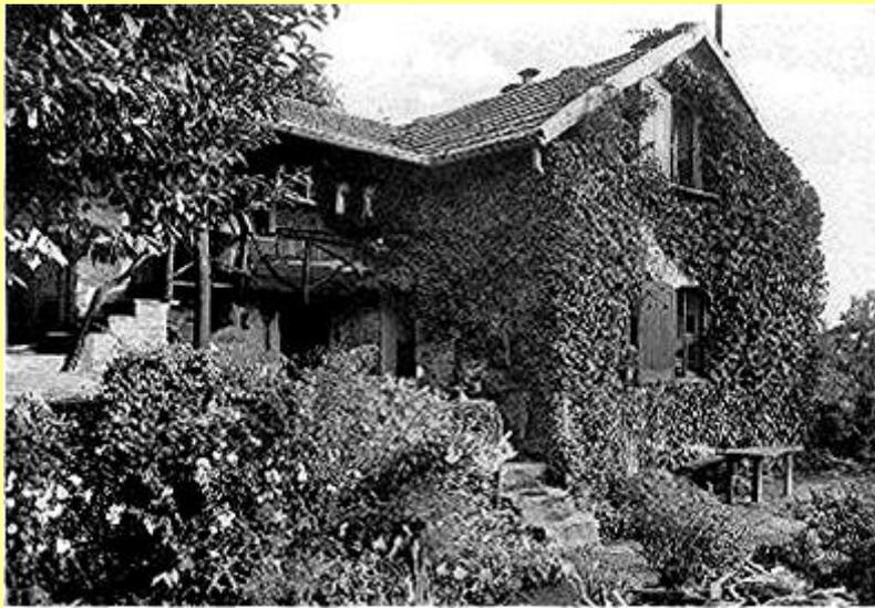
**„Mutters Winkelchen“, vermutlich No 5, 1907 erbaut, „con murature di pietra“ und „piano superiore in strutture di legno a vista“. Die Holzstruktur ist im Seitenflügel noch zu erkennen, die Steinmauer von Efeu oder Weinlaub verdeckt.**
