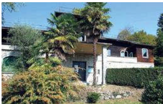
Wasser dringt durch das Dach der Casa Anatta – und auf die Exponate der Ausstellung, die Harald Szeemann dort eingerichtet hat. (Bild: Fotograf/MASSIMO PEDRAZZINI)
