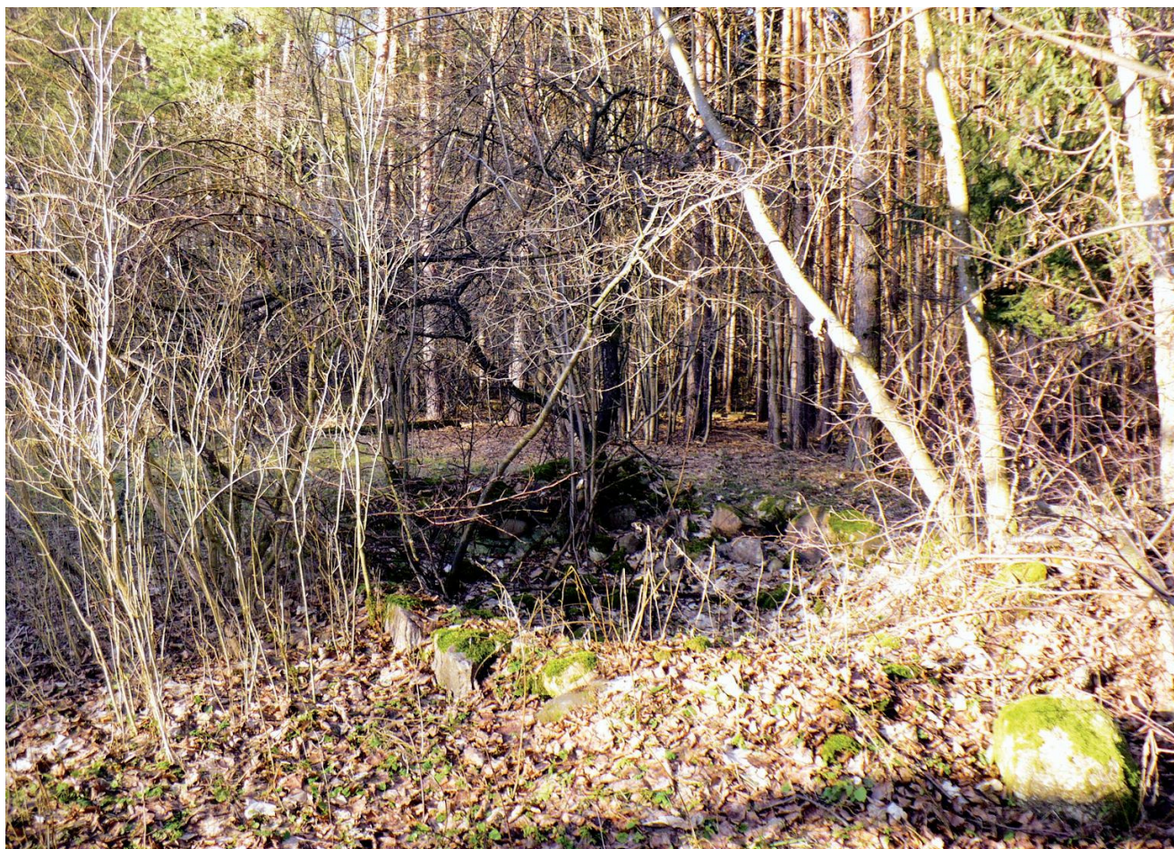
Bild 43: Die Fundamentreste von Grünhorst
